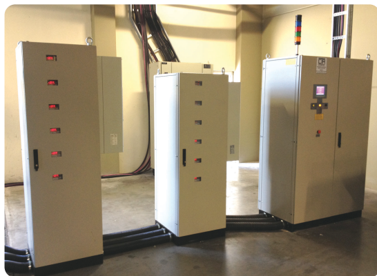
PAINÉIS ELÉTRICOS DEDICADOS COM IHM TOUCHSCREEN E GERADORES DE ULTRASSOM
